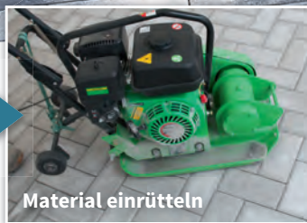
Nachsanden und abrütteln; Danach abfegen
